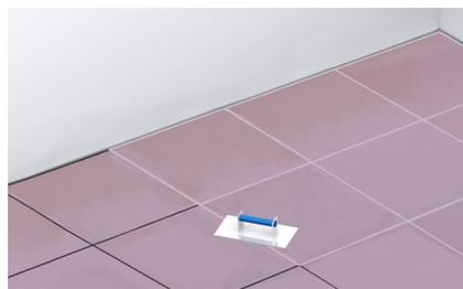
6. Verter ARJUNT® Universal mezclado con resina de látex (140 g/kg de ARJUNT®) para tapar las juntas.
