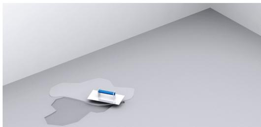
**1.** Limpiar y preparar el soporte con mortero autonivelante ARGONIV® 020 o ARGONIV® 120, eliminando los desniveles.
