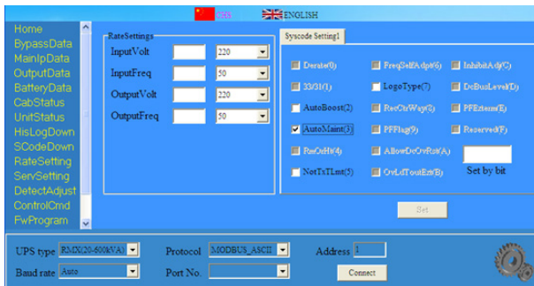
Fig. 94. Activación del período de descarga automática de mantenimiento
