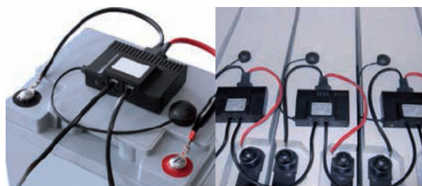
Fig. 32. Sistema control y análisis de baterías BACS
