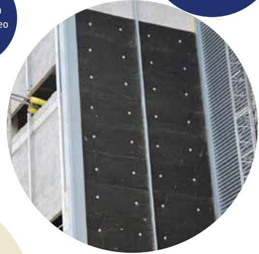
La lana mineral colocada en la cara exterior permite transpirar al cerramiento evitando la formación de condensaciones
