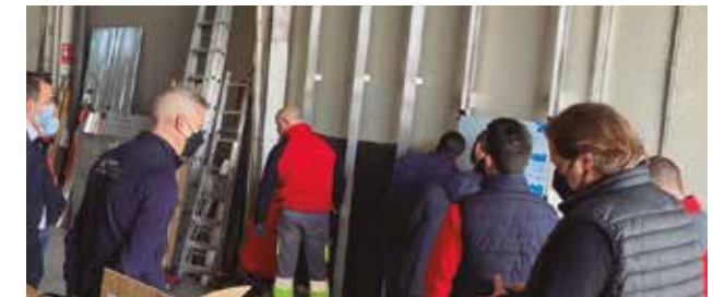
Alicante - Proceso de Instalación de una fachada ventilada en colaboración con TRESPA
