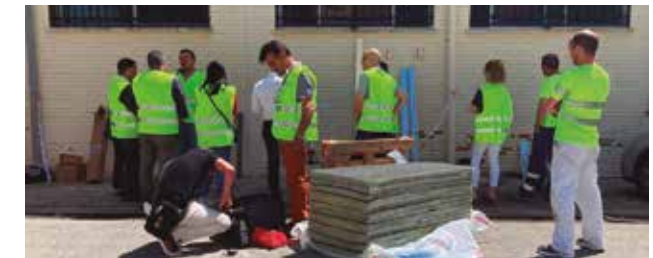
Sevilla - Formación con Trespas y Hilti sobre cómo se instala una fachada ventilada
