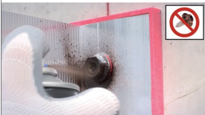
Figura 30. Aerosol bituminoso de protección frente a la corrosión ambiental.
