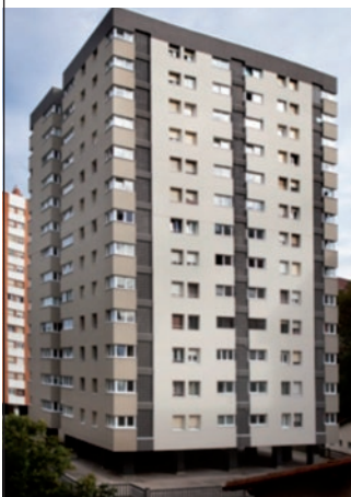
Figura 137. Rehabilitación edificio ubicado en c/ Larratxo de San Sebastián, sistema de fijación atornillada y revestida in situ, fachada ventilada revocada sin juntas, año 2011, altura del edificio 44 m.
