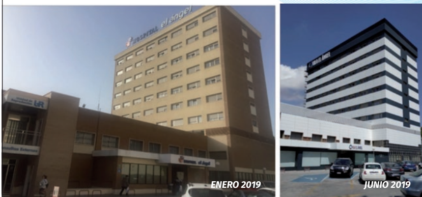
Figura 49. Rehabilitación Clínica El Ángel de Málaga. Fijación oculta modular.
