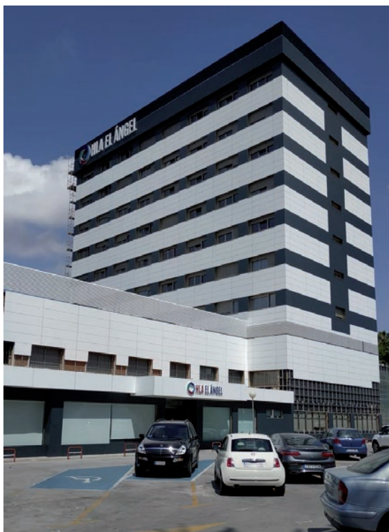
Ejemplo de Rehabilitación Clínica El Ángel, Málaga.
