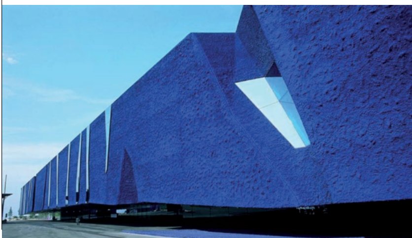
Figura 138. Obra nueva. Edificio Fórum de Barcelona, sistema de fijación atornillada y revestida in situ, fachada ventilada revocada sin juntas, año 2005, altura del edificio 25 m .
