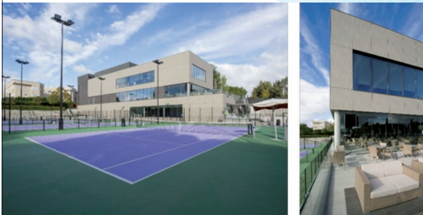
Figura 47. Club David Lloyd Aravaca en Madrid. Fijación oculta mecánica.
