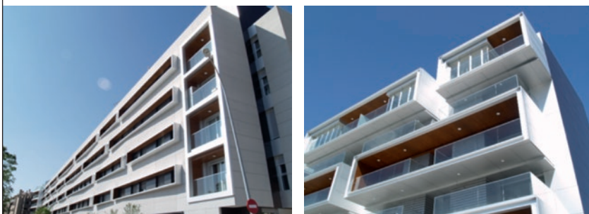
Figura 158. Viviendas Isla de Arosa (Alcalá de Henares - Madrid). Panel composite.
