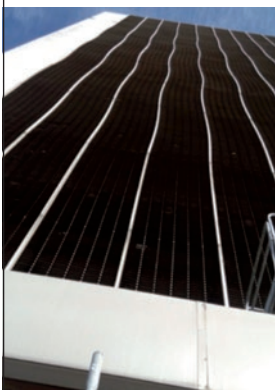
Figura 35. Ejemplo real de perfiles dilatando unidos de manera rígida.
