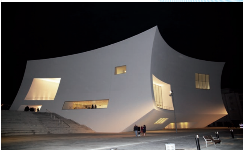
Figura 136. Obra nueva Palacio de Congresos de Águilas en Murcia, sistema de fijación atornillada y revestida in situ, fachada ventilada curvada, revocada y sin juntas, año 2010, altura del edificio 26 m.
