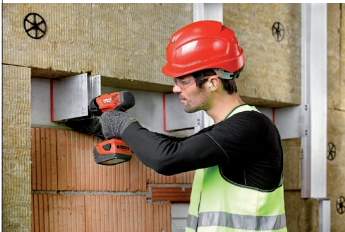
Figura 200. Sistema S2S de forjado a forjado.
