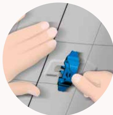
6. **Asegurar** la fijación presionando con la mano el clavo azul del cabezal.
