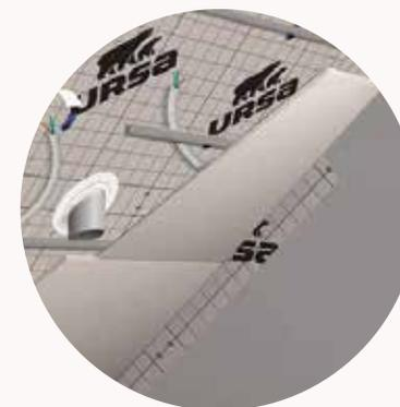
7. **Encajar** los perfiles metálicos en los cabezales de la fijación azul. Instalar los conductos eléctricos entre la membrana y las placas de yeso laminado.
