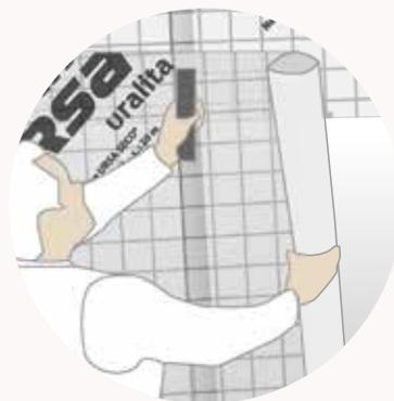
2. **Grapar la membrana** a los montantes o viguetas de madera. Puesto que la membrana está dotada de una elasticidad y una resistencia óptimas, no hay riesgo de rotura y no es necesario sellar las zonas de grapado.
