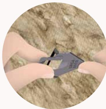
3. **Doblar** el cabezal de la suspensión a 90 grados.
