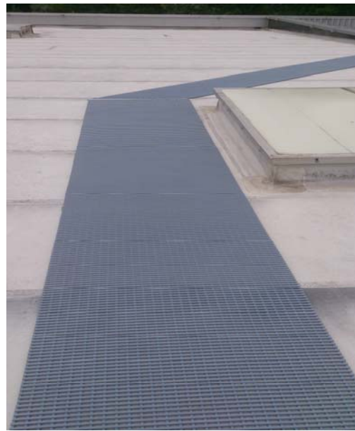
Figure 23 - Mise en place du DANOGRID PVC
