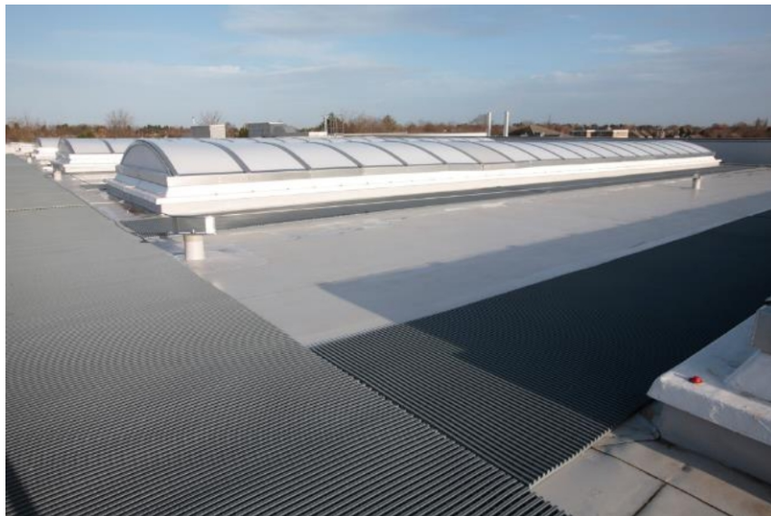
Figure 33 : Mise en place du DANOGRID PVC
