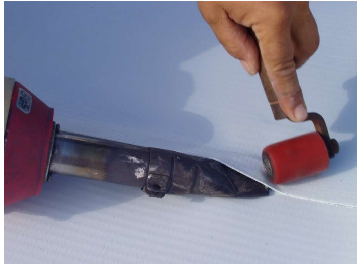
Figure 1 : Soudure de la membrane DANOPOL HS
