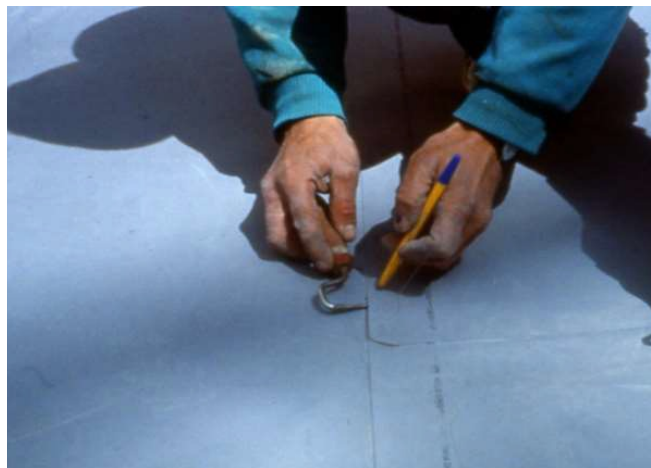
Figure 2 : Contrôle des soudures à la pointe sèche
