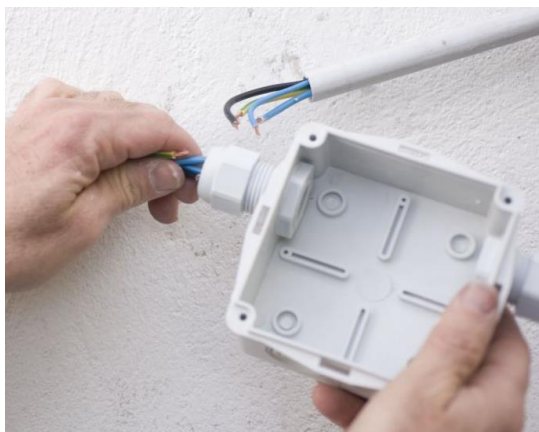
Figura 116. Instalación de caja universal estanca de superficie.
