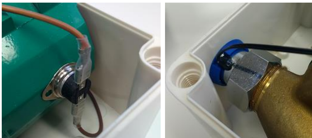
Figura 94. Sonda de temperatura y termostato en el módulo de potencia (1 y 4).
