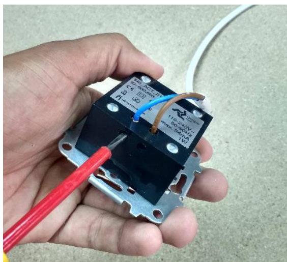
Figura 44. Atornillado de los hilos del cable a las clemas del módulo de activación (3).
