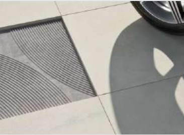
Colocación con cola de adhesivo Laying on screed with adhesive
